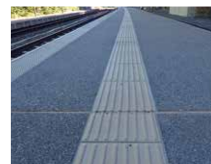
Bahnsteigoberfläche mit Blindenleitsystem als Betonabguss
