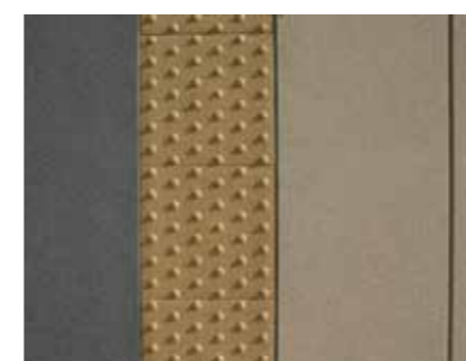
Zweifarbige Oberfläche mit eingeklebter Fliese (Großbritannien)
