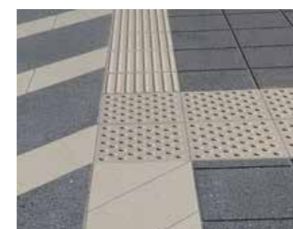
Bahnsteigoberfläche mit integrierten Scheinfugen
