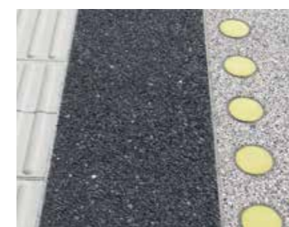
zweifarbige Oberfläche mit eingeklebten „yellow dots“, (Dänemark)
